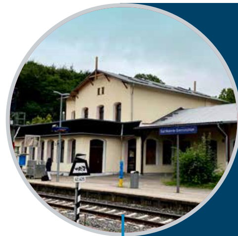
Bahnhofsgebäude Bahnhof Bad Malente-Gremesmühlen
